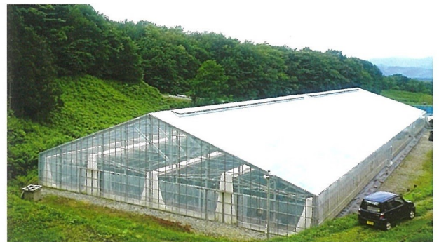
大型鉄骨ハウス
